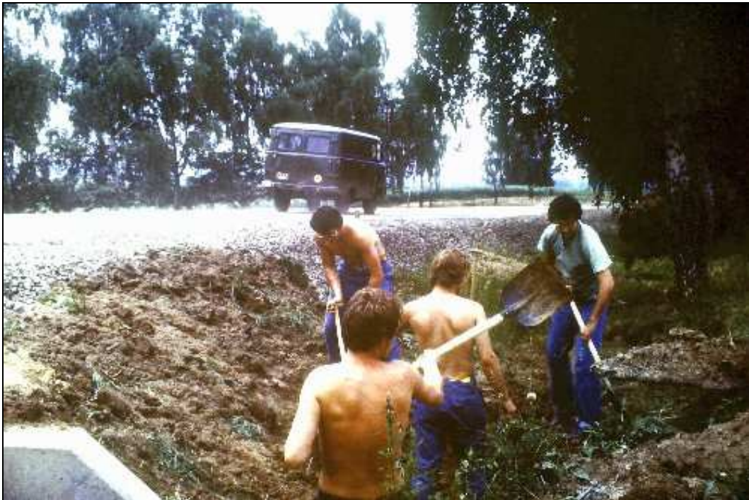
Auf den Straßenbaustellen haben wir meist nach der chinesischen Methode gearbeitet: So viele Leute wie möglich stürzten sich intensiv auf das Problem!
