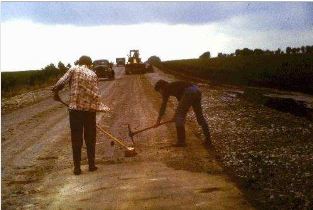
Auch diesen Job haben wir erledigt: Straßen wurden zum Abschluss gefegt!
