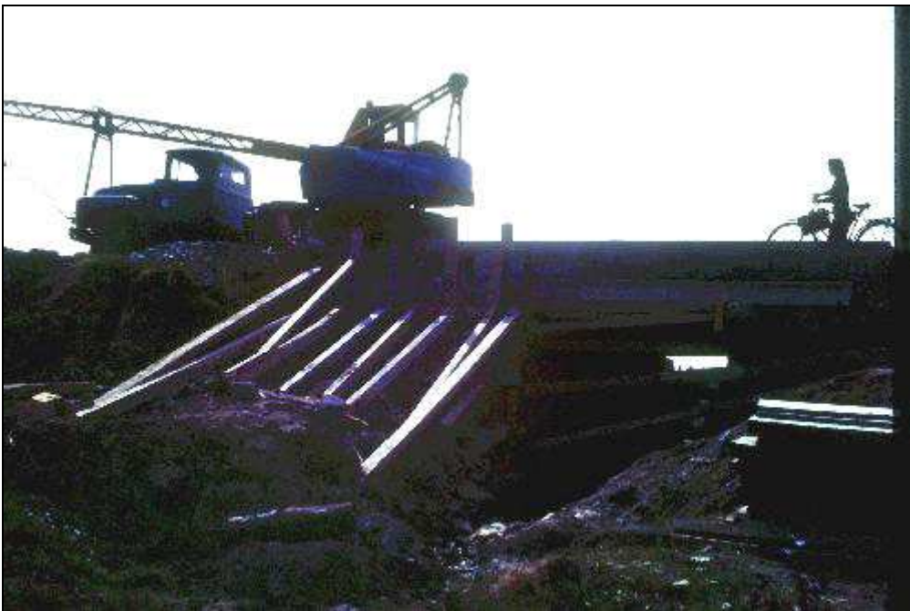
Auch an dieser Straßenbrücke haben wir Studenten zeitweise mitgeholfen.
