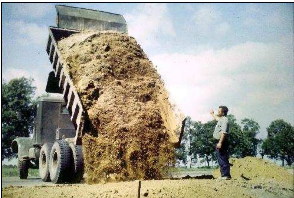
... und dann lud dort ein Laster den Sand für den neuen Straßenrand ab!
