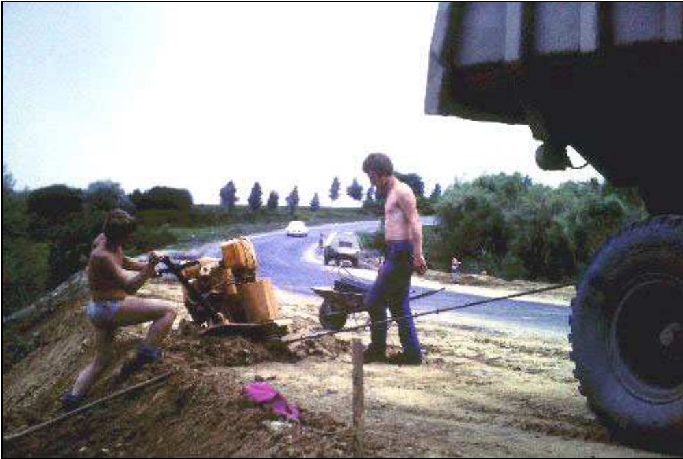
Beim Verdichten eines Seitenstreifens versinkt die Rüttelmaschine im feuchten Untergrund und droht, in den Straßengraben abzurutschen. Studenten packen zu und ein Krass-Kipper zieht das Gerät wieder auf die Straße.
