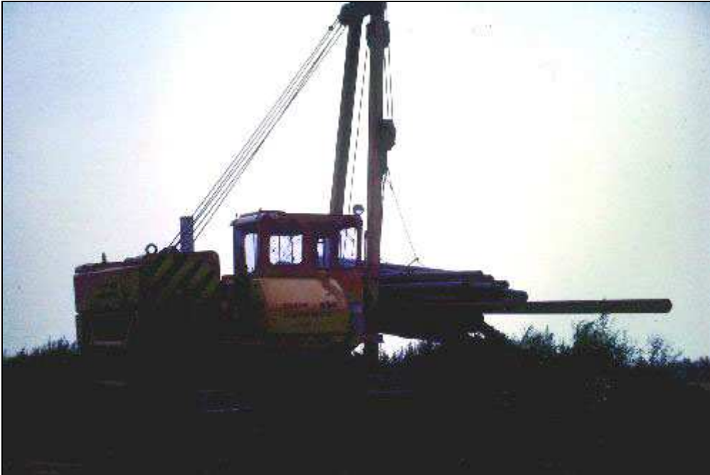
Ein Komatsu-Rohrverlegekran aus japanischer Produktion an einer Baustelle.
