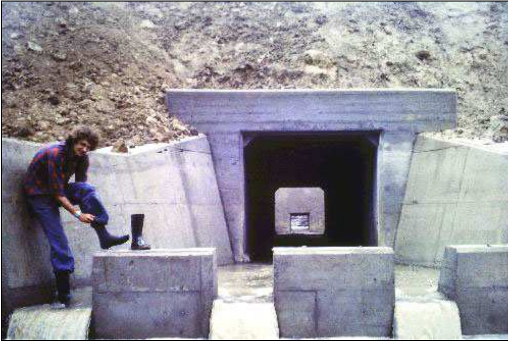
...einer wäscht noch schnell seine Gummistiefel im Wasserbaugraben...
