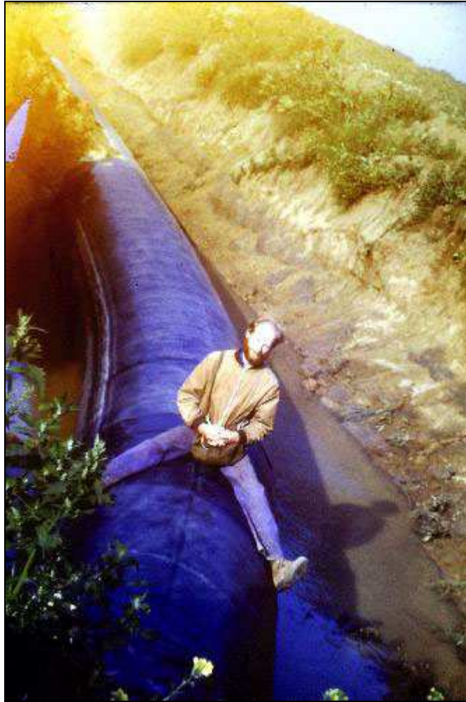
Mein Ritt auf dem Rohr: Irgendwo am Dorfrand lagen noch einige Meter des Gasrohres offen. Als wir im Juli 1978 nach Gaisin kamen, war der Rohrstrang bereits fertig. Wir Studenten arbeiteten u.a. als Straßenbau-Hilfsarbeiter!
