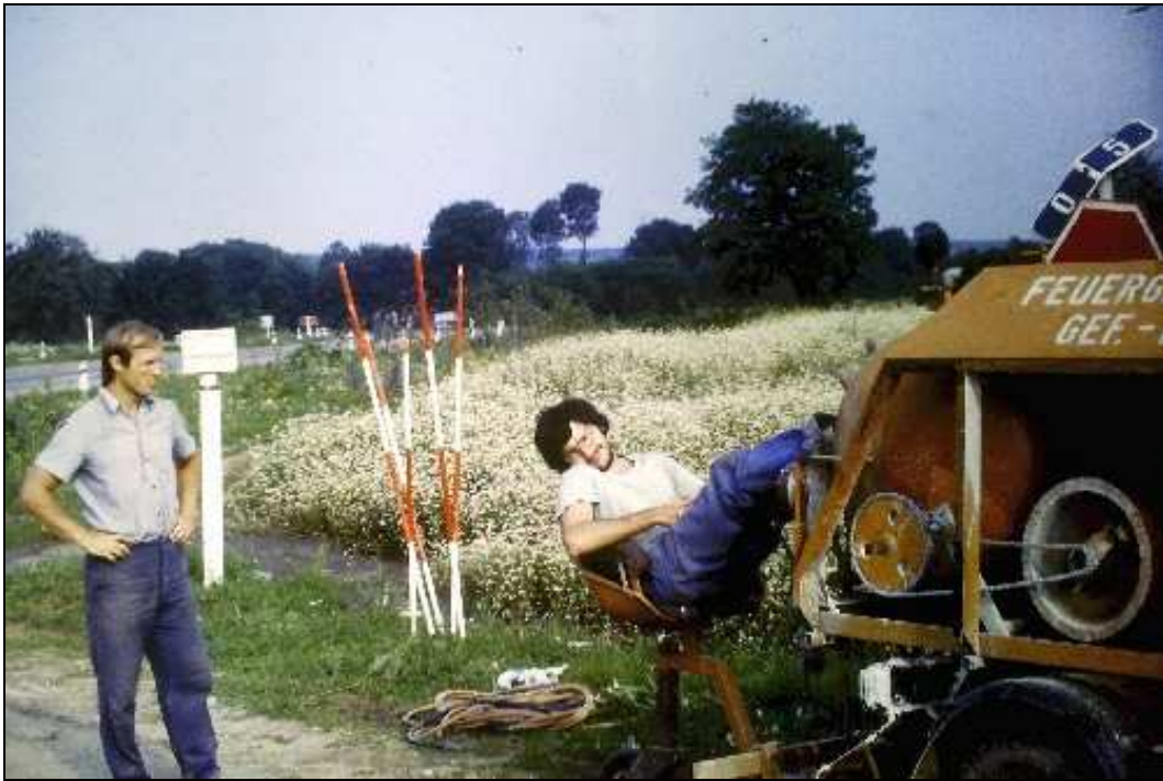
Die letzte Arbeit auf fertigen Straßen erledigte dieser Student im Sitzen: Er sprühte mit seiner Maschine den weißen Mittelstreifen auf den neuen Asphalt!
