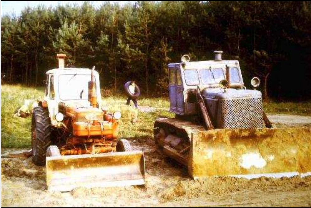
Technik, mit denen die groben Straßenbauarbeiten auch verrichtet wurden!
