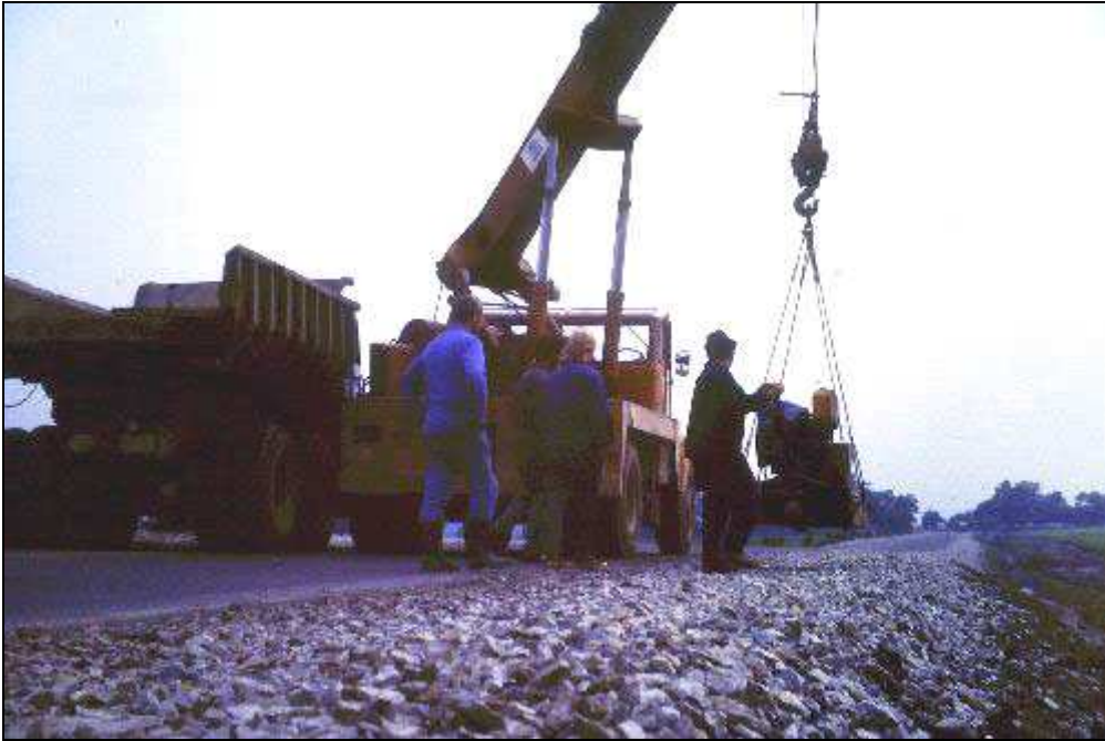
Am Feierabend wurde die Rüttelmaschine sicherheitshalber auf einen Kipper verladen. Der breite schotterige Seitenstreifen (Bankett) ist fast fertig!
