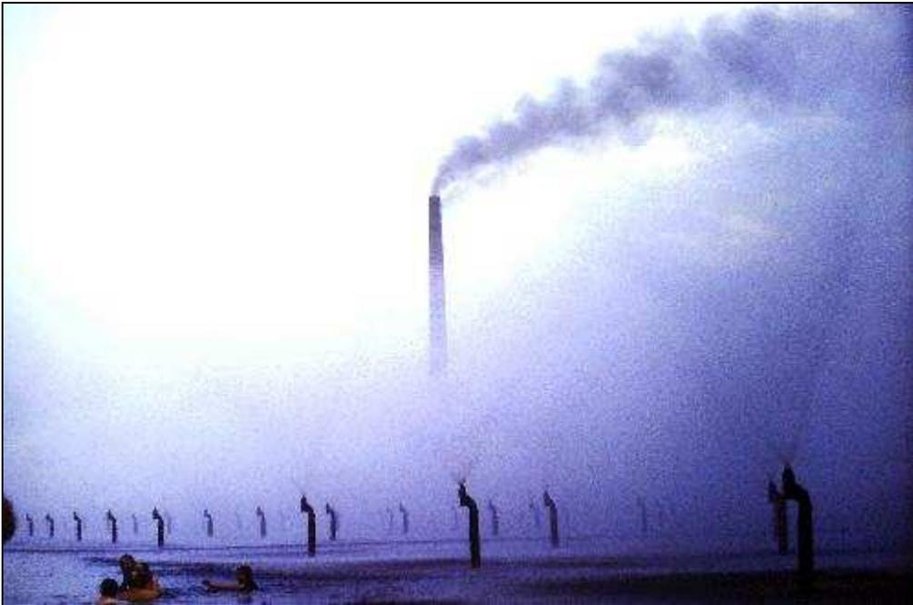
Direkt am Kraftwerk sprühten in einem Becken viele Düsen ständig das Kühlwasser in die Luft, damit es schneller abkühlt. Zu sehen sind im Bildvordergrund auch ein paar Ukrainer/innen, die im warmen Wasserbecken badeten.
